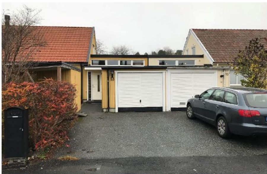
Om- och tillbyggda hus. Förhöjda tak på garagedel för ljusinsläpp i det tidigare atriets.
